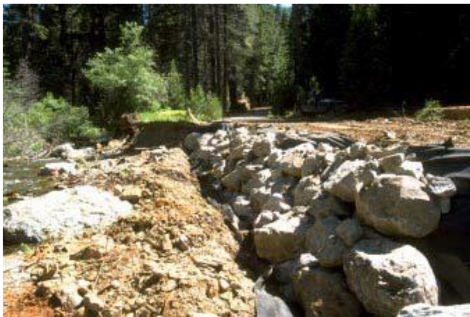
Figura 10: Proteção da estrada contra o alto fluxo de água utilizando riprap e geotêxtil. (Keller et al. , 2003).
