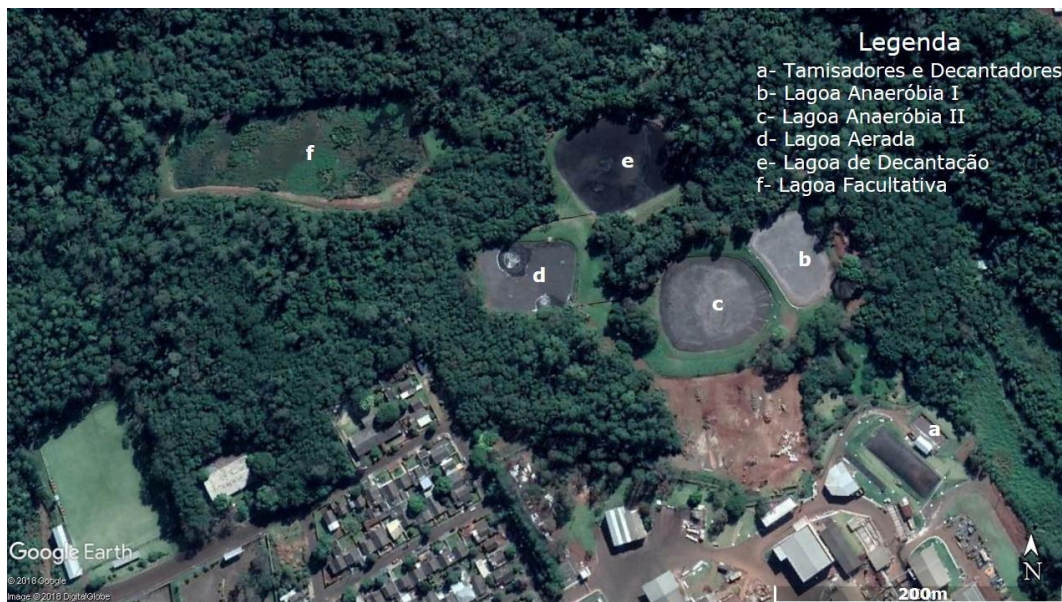
Figura 8. Sistema de tratamento de águas residuais da empresa avaliada. Fonte: Google Earth.
