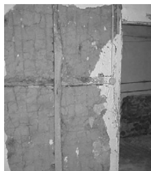
Figura 3: Parede interior com construção tipo Fachwerk .
