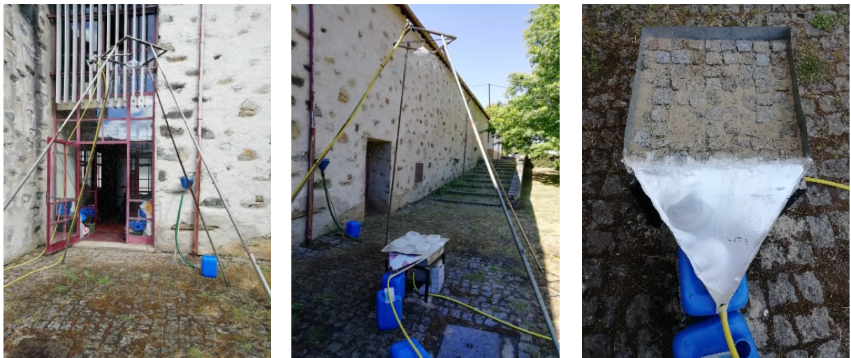
Fig. 57 - Pruebas de infiltración en pavimentos utilizados en zonas urbanas
