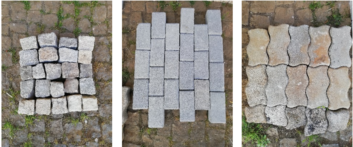
Fig. 56 - Tipos de pavimentos utilizados en zonas urbanas
