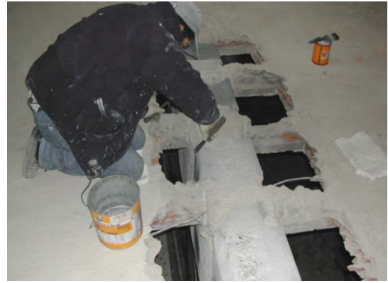
Figura 5.31 – Arredondamento das arestas da viga.
