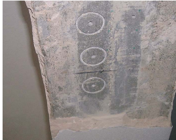
b) Aspecto do betão pré-caroteado.
