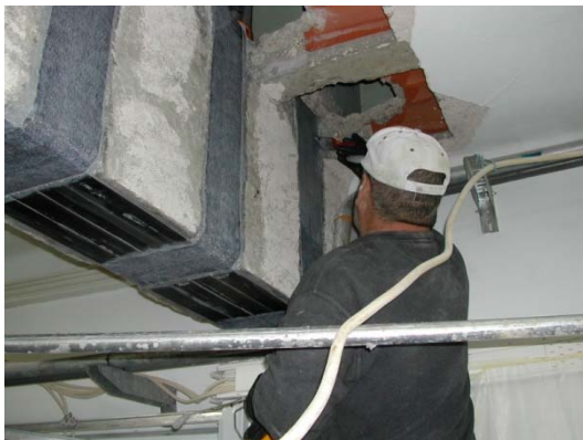
Figura 5.32 – Aplicação do adesivo.
