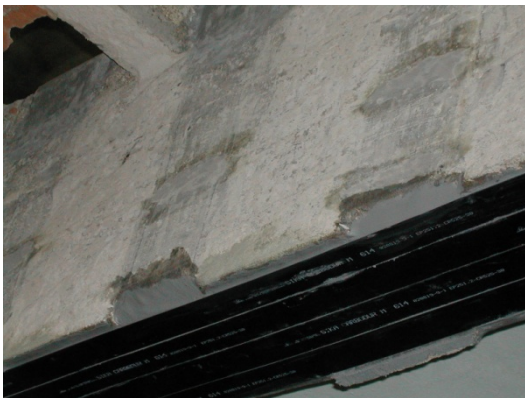
Figura 5.24 – Viga reforçada à flexão.
