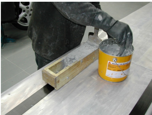
Figura 5.18 – Aplicação do adesivo no laminado.
