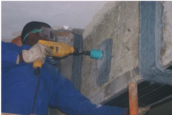
a) Pré-carotagem da superfície.
