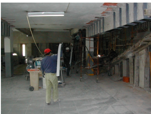
Figura 5.20 – Transporte do laminado.
