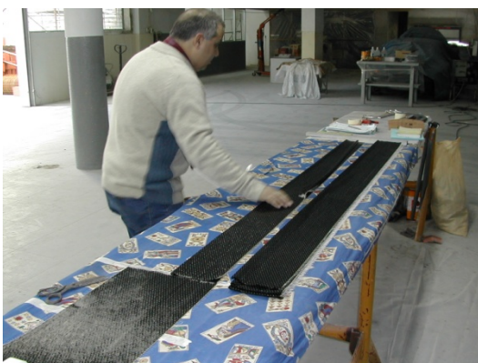
Figura 5.28 – Corte da manta.
