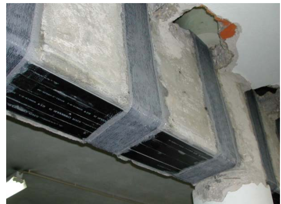
Figura 5.35 – Aspecto da viga reforçada.
