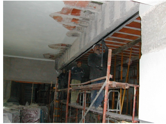
Figura 5.23 – Aplicação no pórtico 9.
