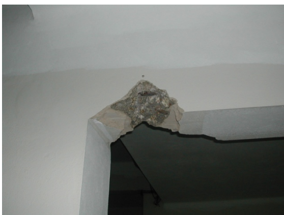
Figura 5.8 – Recobrimento junto de um pilar
