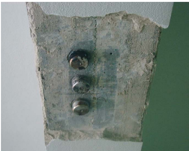
c) Pastilhas metálicas coladas na viga.
