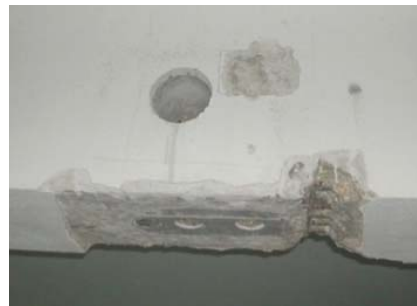
Figura 5.7 - Aspecto da zona da viga após a extracção da carote.
