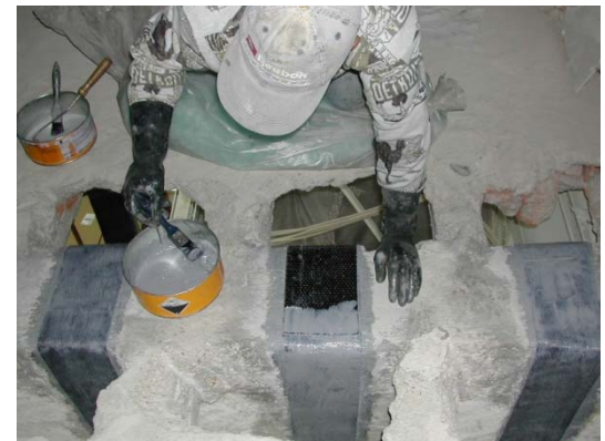
Figura 5.33 – Preparação para receber nova camada.
