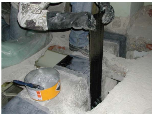
Figura 5.34 – Esticamento da nova camada.
