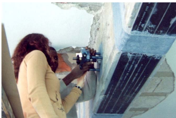
e) Posicionamento da maquina de Pull-Off .
