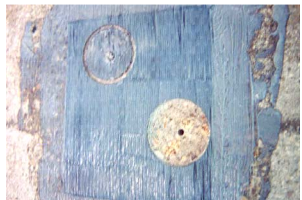
f) Aspecto após execução do ensaio.
