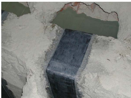
Figura 5.36 – Empalme na face superior da viga.
