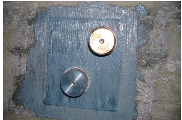
d) Pastilhas metálicas coladas sobre o CFRP.
