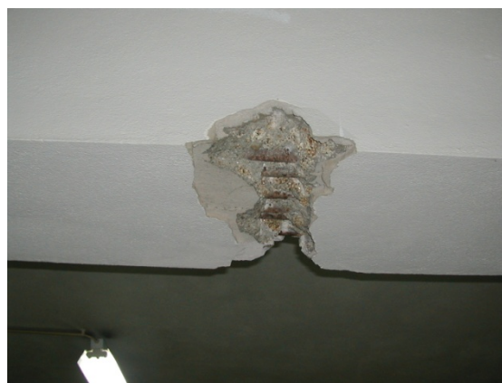
Figura 5.9 – Recobrimento a meio vão
