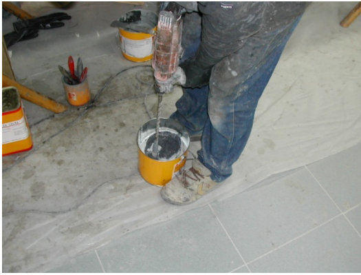
Figura 5.14 – Mistura dos componentes do adesivo.
