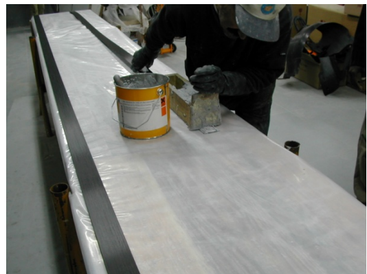
Figura 5.19 – Aplicação do adesivo no laminado.
