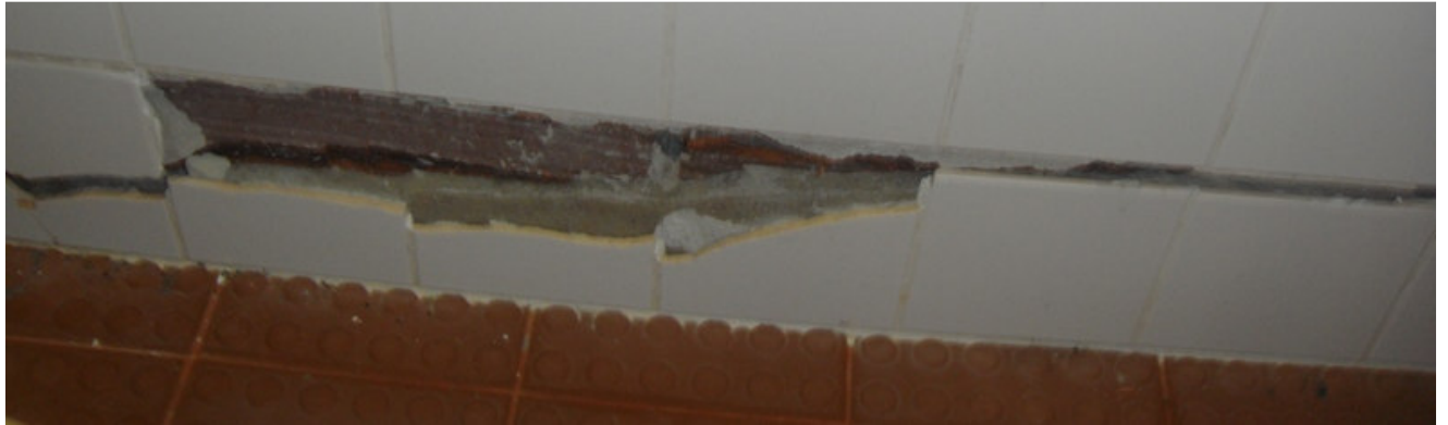
Figura 8 – Fissuras nas paredes do balneário
