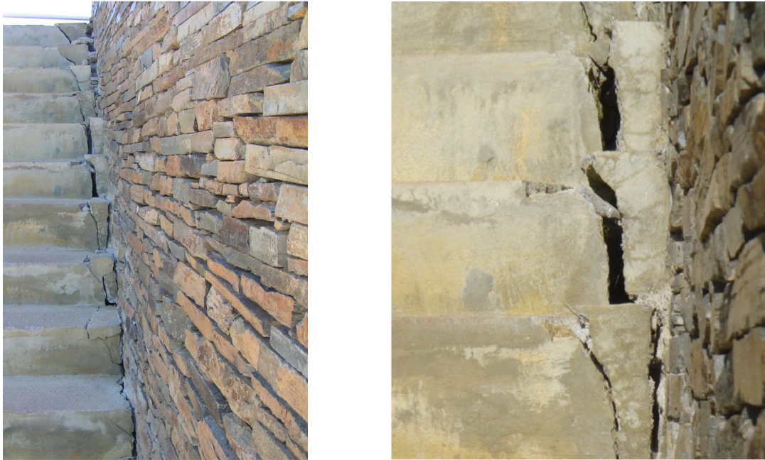
Figura 10- Assentamento das escada exterior de acesso ao balneário
