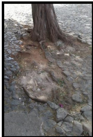
Figura 54 - Rua 10 do Bairro Ribeira Bote/Torrada (Março, 2017)
