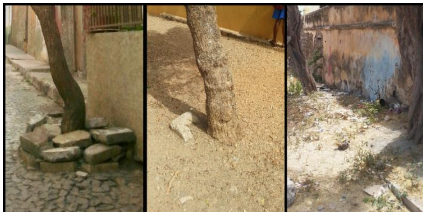
Figura 14 - Caldeiras inapropriadas e solos inadequados - Fonte: Arquivo do autor (Março, 2017)
