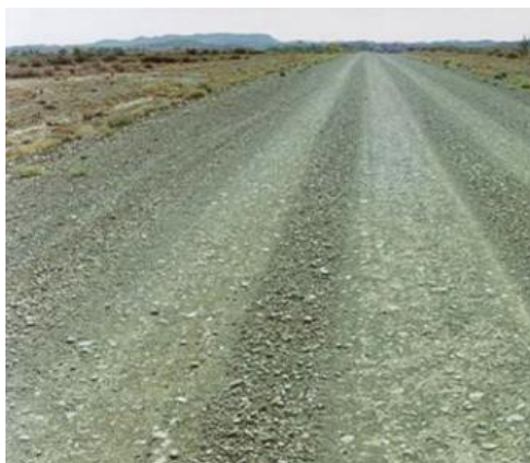
Figura 19 - Fotografia de uma estrada não pavimentada com agregado solto em sua superfície Fonte: ARRB, 2009.
