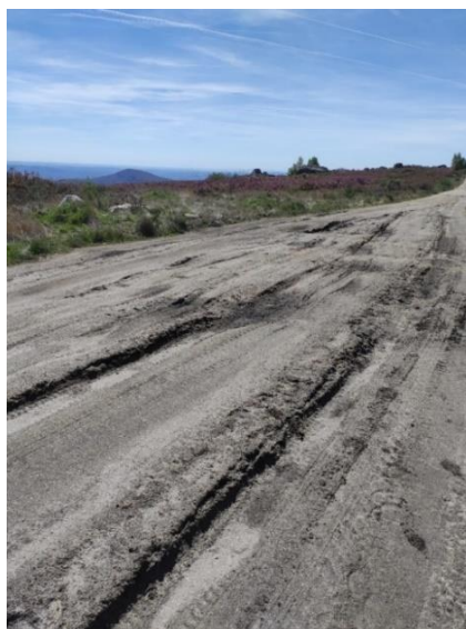
Figura 18 - Afundamento e buracos na EBVT não pavimentada de Montesinho em 2023
