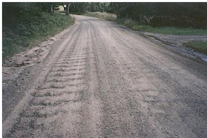
Figura 16 - Fotografia de uma estrada não pavimentada com ondulações em sua superfície Fonte: Austroads, 2009.
