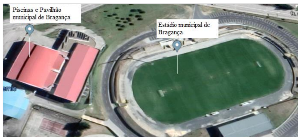
Figura 41: Vista área das Piscinas e Pavilhão municipal e Estádio municipal de Bragança.
