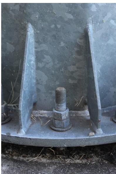
Figura 17: Detalhes da ligação torre-flange. Fonte: A autora.
