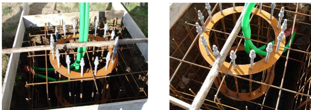
Figura 11: Escavação e alocação das armaduras. Fonte: Acervo do IPB.
