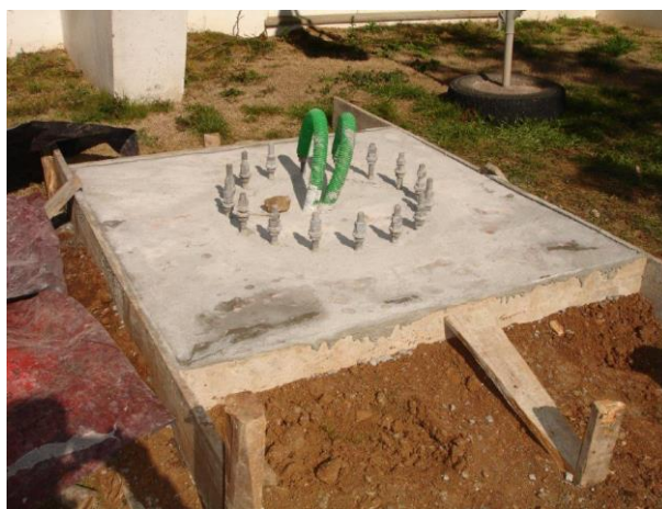
Figura 12: Concretagem e porcas de nivelamento. Fonte: Acervo do IPB
