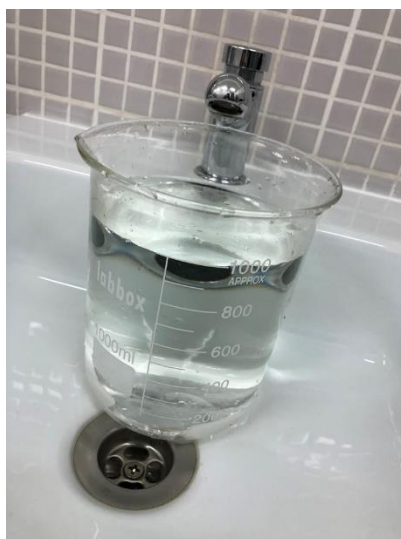
Figura 3.3: Medição de caudal debitado por torneira de lavatório.
