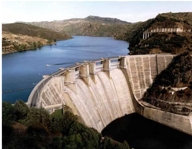
Figura 39: Central hidroeléctrica de Bemposta
