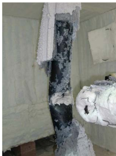
Figura V.201 – Removida parte da camada intumescente do elemento.
