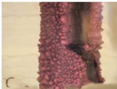
Figura V.173 – Formação da retracção na camada intumescente.
