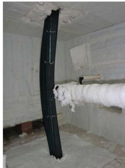
Figura V.211 – Deformação final imposta ao elemento.
