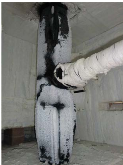
Figura V.147 – Visualização do elemento na zona onde a camada não retraiu.
