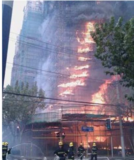
Figura 3 – Incêndio de uma estrutura exterior no edifício em Xangai, 2010 (Safety, 2010).
