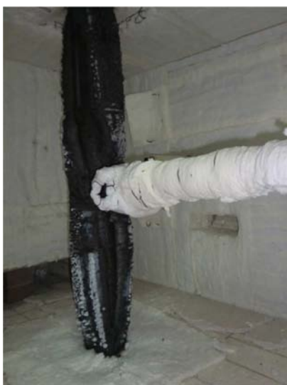
Figura V.174 – Final do ensaio, com a visualização do estado da camada intumescente.
