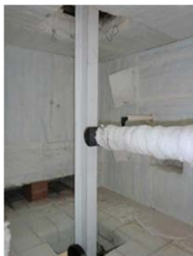
Figura V.78 – Elemento instalado nos apoios.
