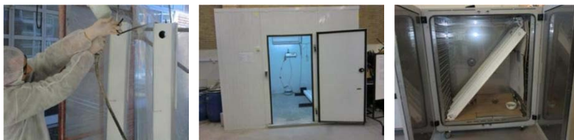
Figura 49 – Fases de pintura dos elementos (pintura, controlo dimensional e acondicionamento).
