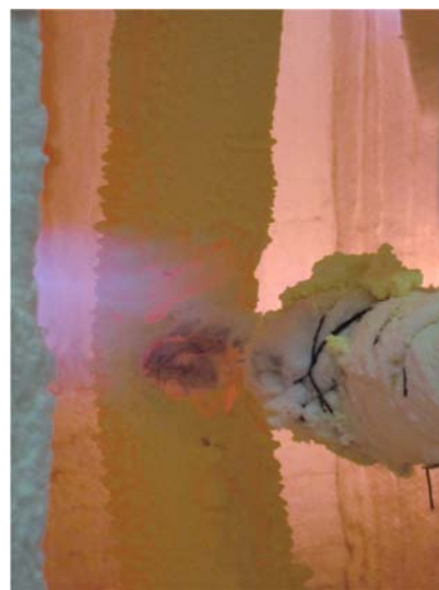
Figura V.171 – Pormenor da rótula plástica formada durante a ruptura do elemento.
