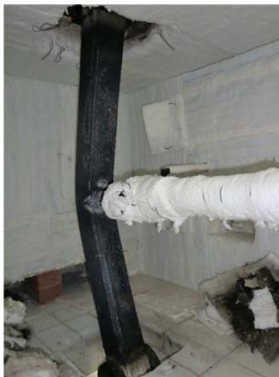
Figura V.136 – Estado de deformação imposto ao elemento.
