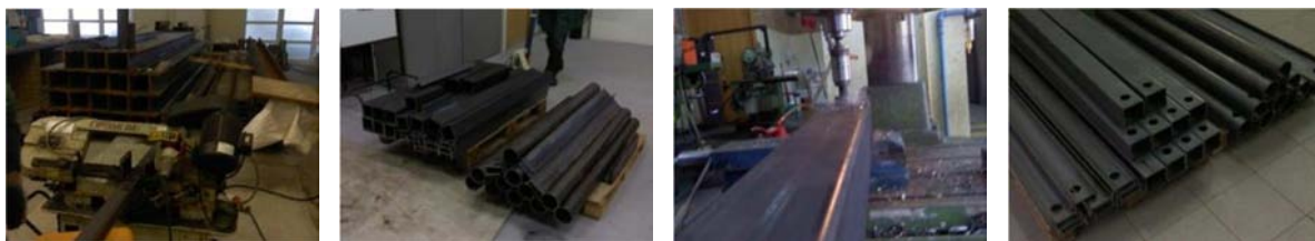
Figura 34 - Corte e furação dos elementos.
