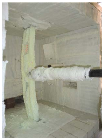
Figura V.97 – Deformação do elemento após o final de ensaio.
