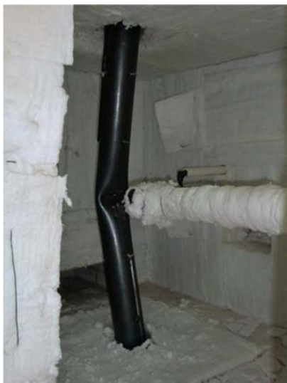
Figura V.160 – Estado de deformação do elemento no final do ensaio.
