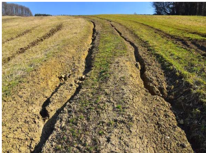
Figura 11 – Erosão em sulcos
