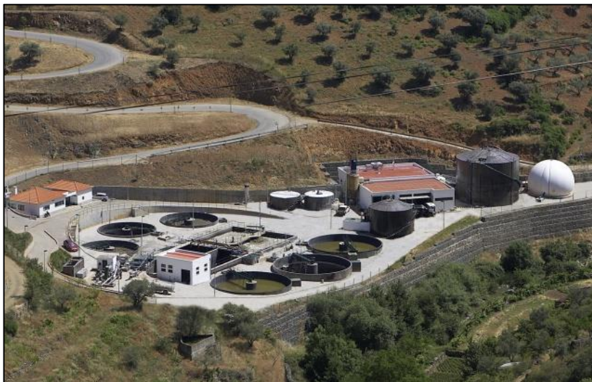
Figura 9. Vista panorâmica da ETAR de Bragança Fonte: Águas do Norte, 2016.
