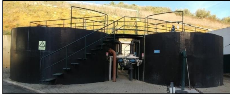
Figura 14. Espessadores gravíticos das lamas primárias e secundárias
