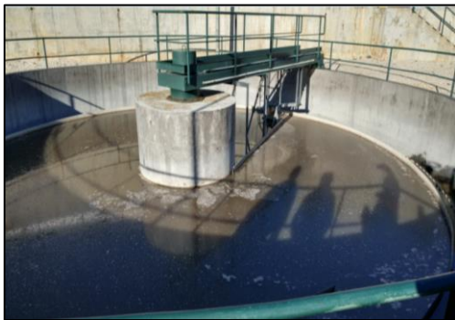
Figura 12. Decantador primário
