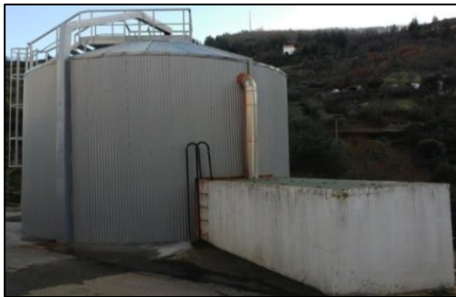
Figura 15. Digestor anaeróbio
