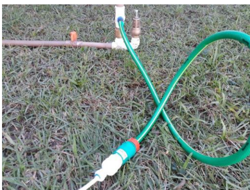
Figura 8 - Sistema de Acomplamento Carneiro Hidráulico - Filtro de Osmose Reversa
