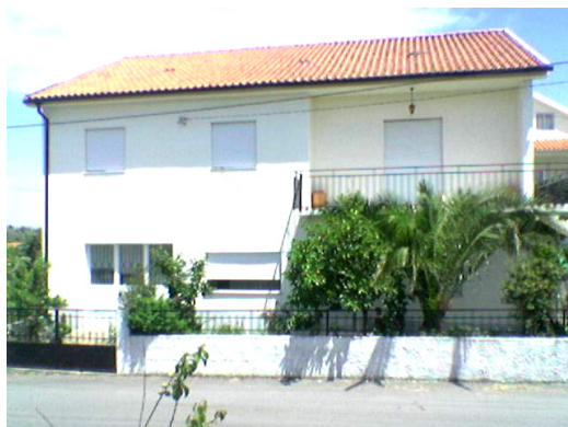
Figura 2 – Edifício tipo do grupo das habitações individuais.
