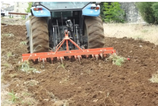
Figura 4.3 - Regularização superficial do solo com escarificador
