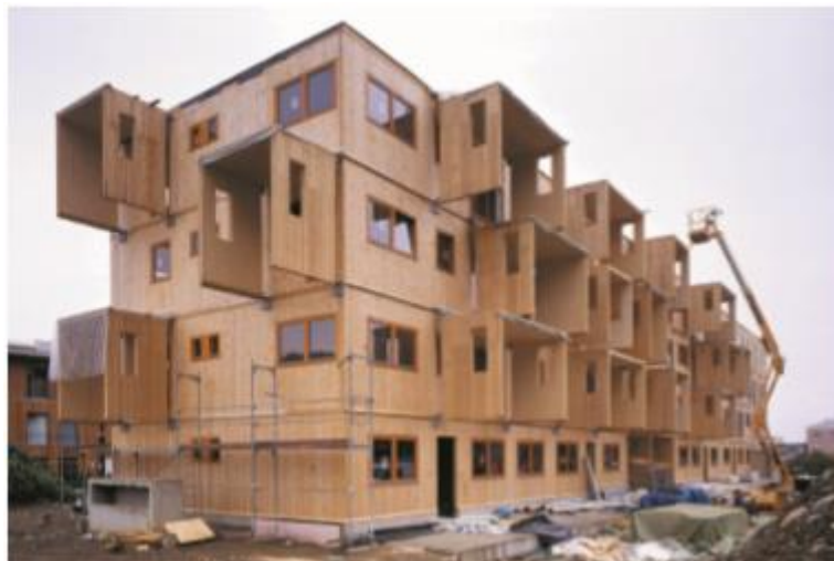
Figura 9 Edifício Multi-familiar em construção situado em Judenburg, Áustria. [27]
