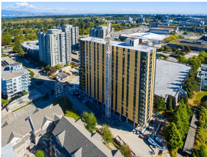
Figura 5 Brock Commons Tallwood House , em Vancouver, Canadá, [18].
