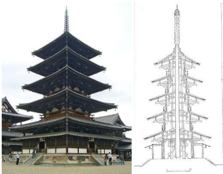
Figura 4 Templo budista Horyu-ji, construção registrada mais antiga de madeira, [16].
