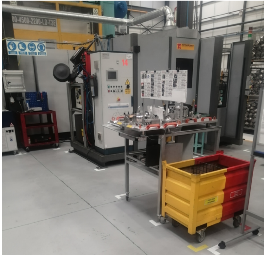
Figura 4.13: Aplicação do seiso na linha de soldadura
