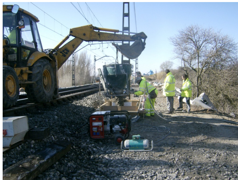
Foto 18. .Hormigonado de macizos de electrificación.
