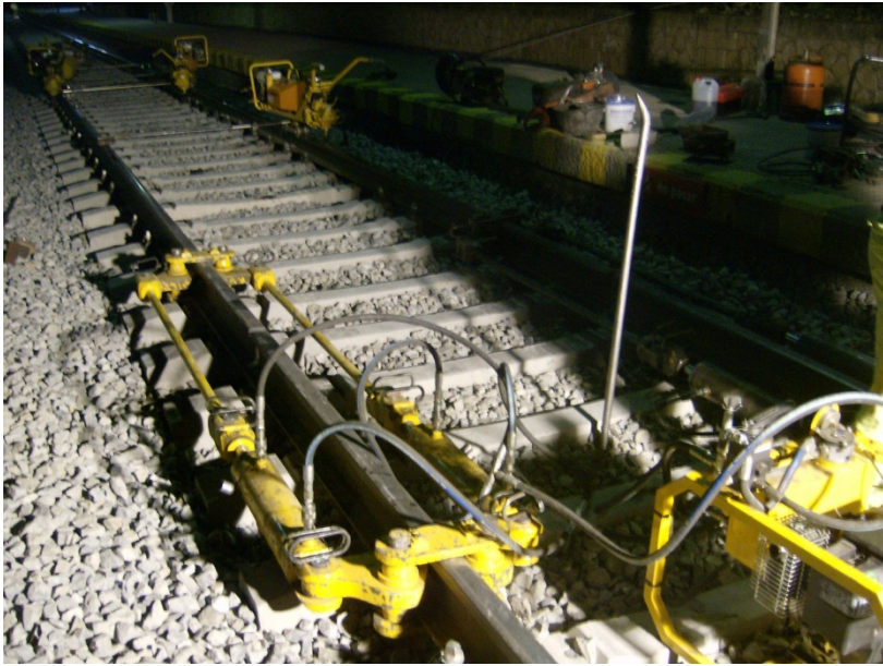
Foto 21. Liberación de tensiones en carril
