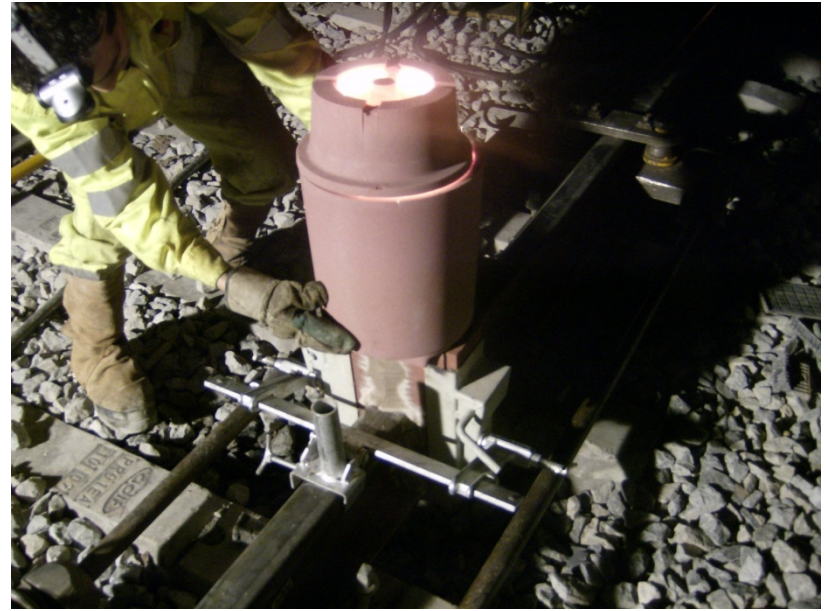
Foto 22. Soldadura aluminotérmica de carril
