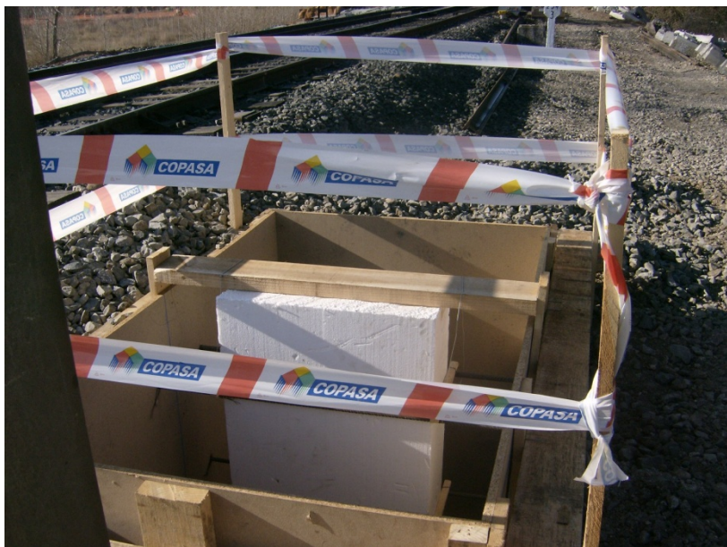
Foto 17. Encofrado de macizos de electrificación
