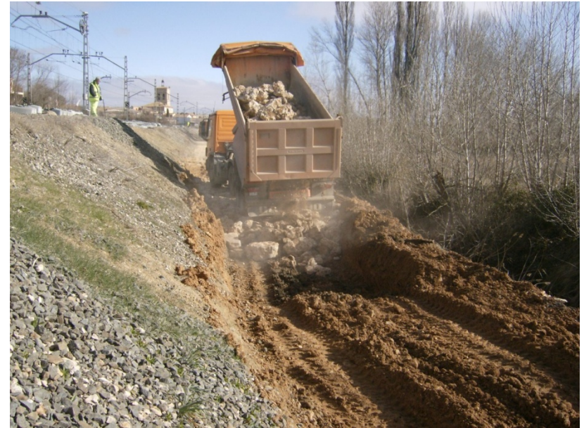
Foto 14. Colocación de piedra en el terraplén.
