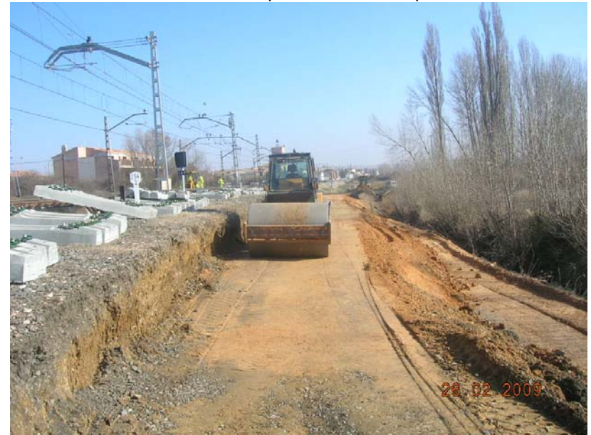
Foto 14. Colocación de piedra en el terraplén.
