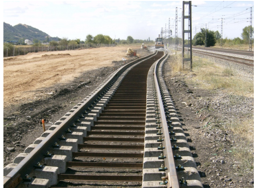
Foto 4. Construcción vía 6 para apartado de maquinaria
