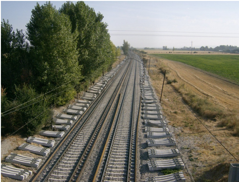
Foto 3. Acopio de materiales a lo largo de la vía.
