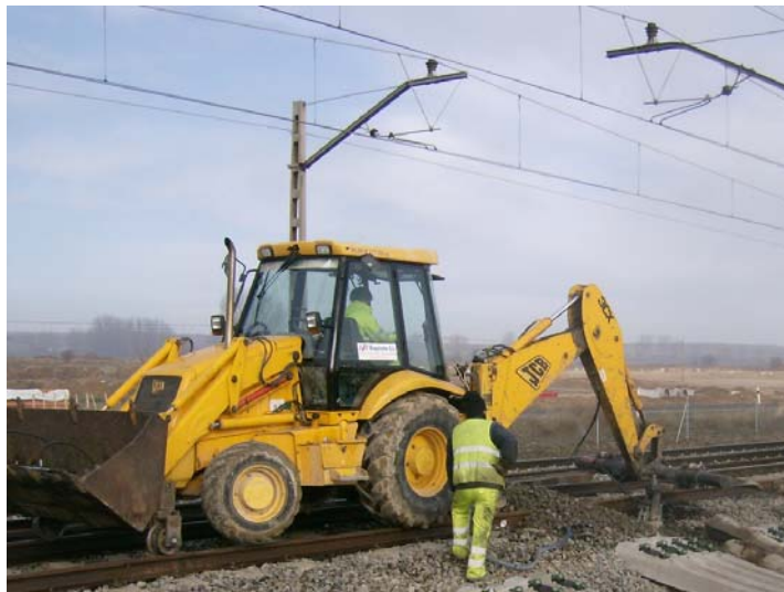
Foto 6. Retroexcavadora para cambiar traviesas.
