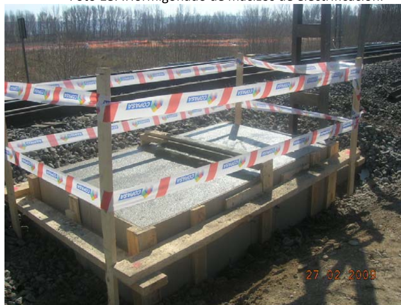
Foto 18. .Hormigonado de macizos de electrificación.
