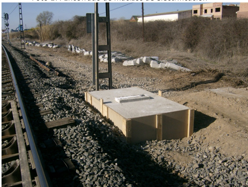
Foto 17. Encofrado de macizos de electrificación
