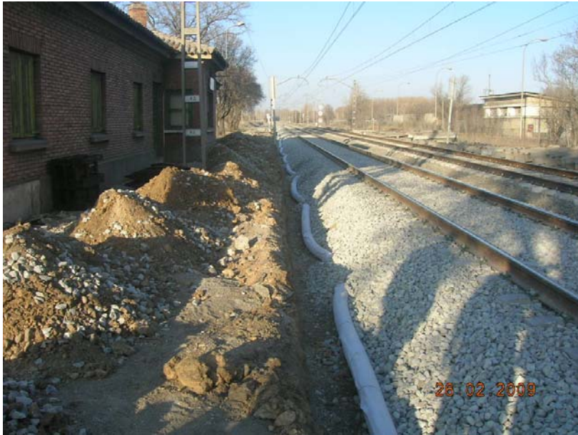
Foto 13. Tubo de drenaje para la vía.
