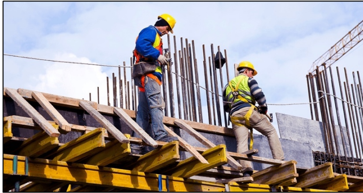
Figura 06 - Realização de Atividades em Telhados e Coberturas com Equipamentos Adequados.
