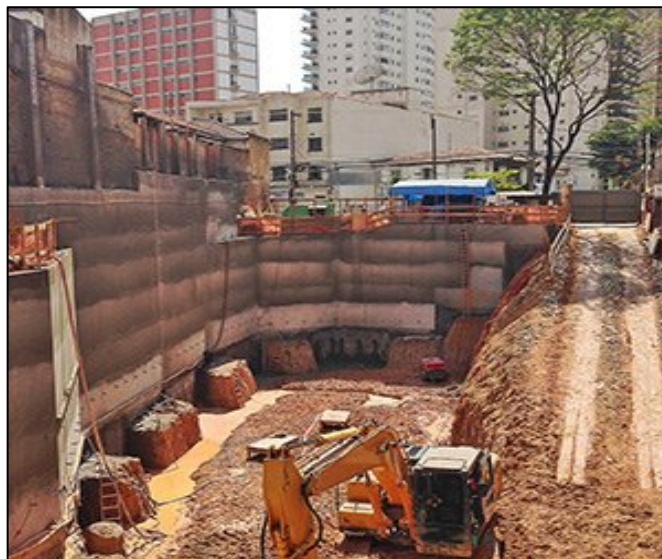
Figura 03 - Área Destinadas a Realização das Atividades de Escavações e Fundações.
