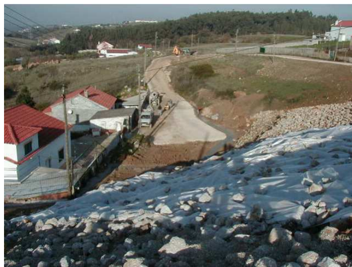
Figura 15 - Vista do Topo do Talude. (Fonte: Martins, Nogueira e Carvalho, 2012)
