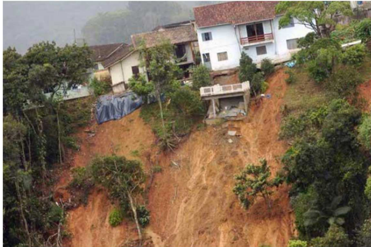
Figura 14 - Deslizamento em Itajaí - Brasil. (Fonte: Garcia, 2018)
