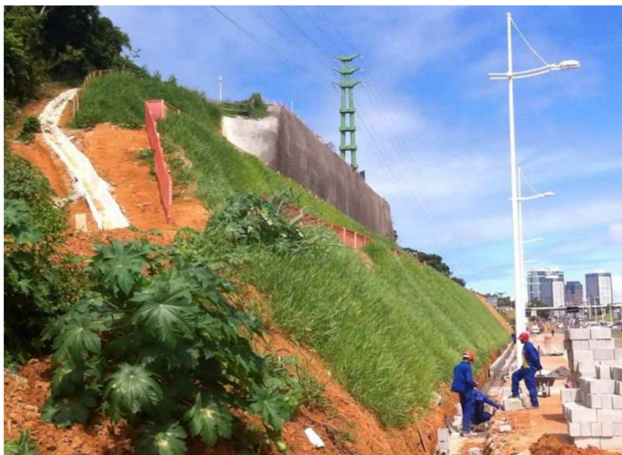
Figura 18 - Esquema de divisão do talude. (Fonte: H. Souza, R. Santos e W. Carneiro, 2014)
