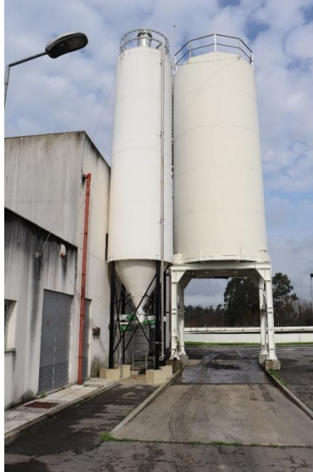
Figura 24 - Silo para armazenamento de lama.
