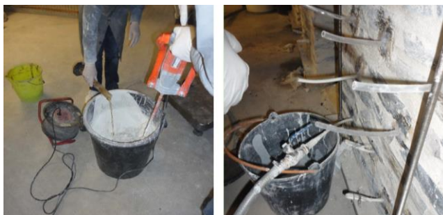
Figura 1. (a) Preparação da calda (b) Injeção de uma parede
