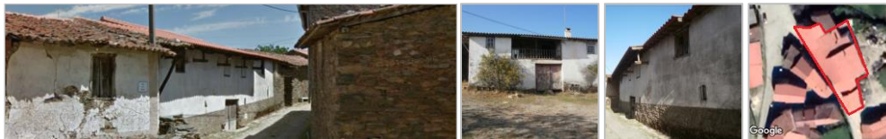
Figura 6: Estudo de caso 2 - Edificação existente.
