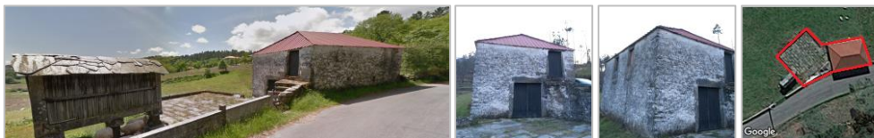
Figura 3: Estudo de caso 1 - Edificação existente.
