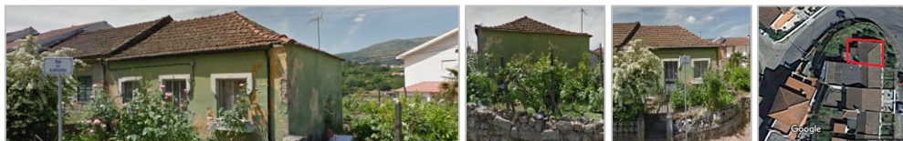
Figura 9: Estudo de caso 3 - Edificação existente
