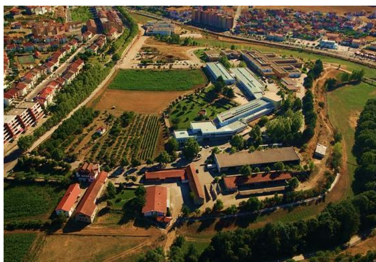
Figura 6 - Vista aérea do Campus de S ta . Apolónia do IPB [41].
