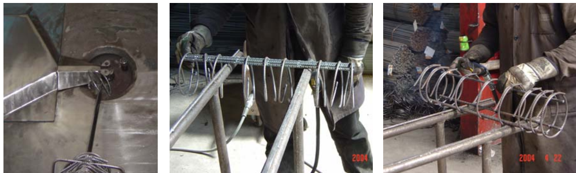
Figura 2.14 – Execução das armaduras.
