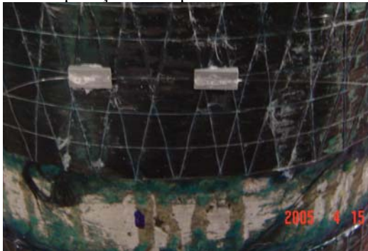
Aspecto final do extensómetro de fibra óptica
