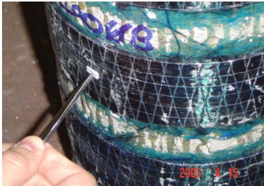
Aplicação dos suportes em alumínio
