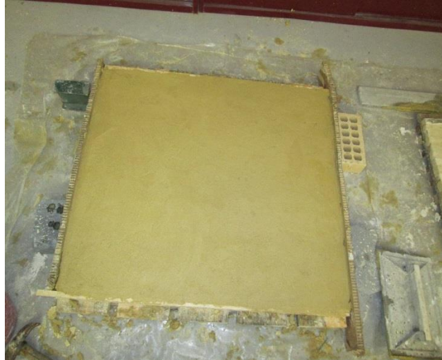
Figura 14 – Parede de tabique preenchida com argamassa argilosa.
