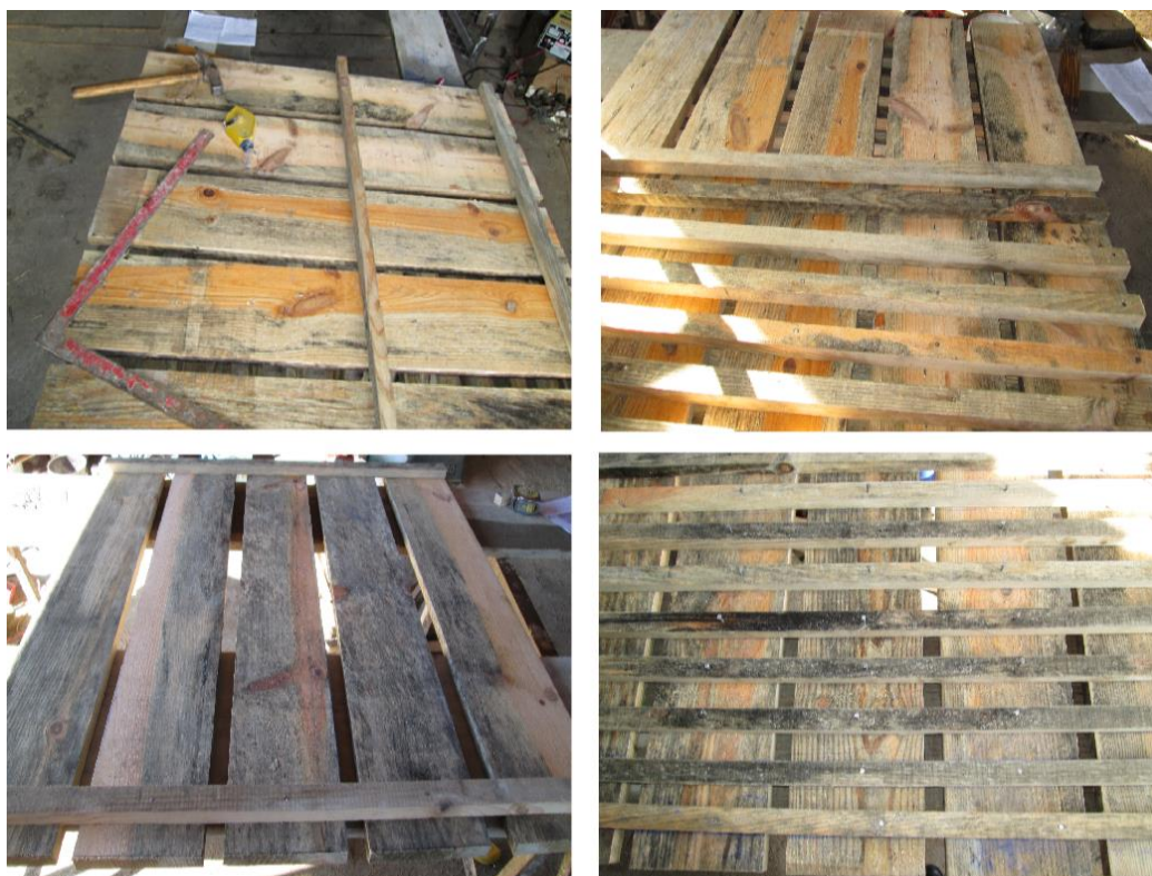
Figura 27 – Construção da estrutura de madeira da parede em tabique.
