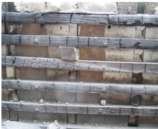
Figura 43 – Resultado da Parede Teste, face exposta ao fogo após o ensaio.
