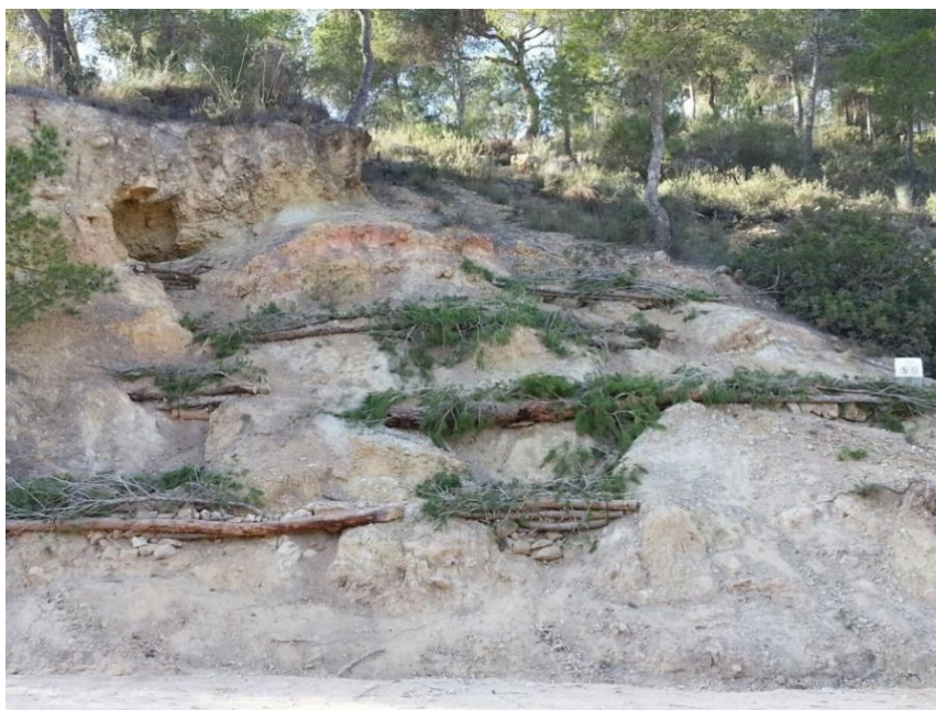
Figura 10 - Técnica de estabilização utilizada no controle à erosão denominada barreiras (Miguez, 2014).
