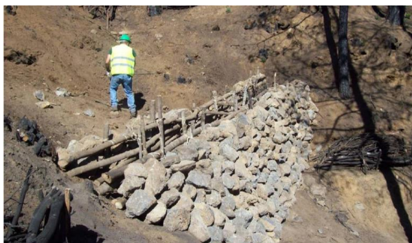
Figura 11 - Estrutura de pedra usada para construção de diques com o intuito de conter erosão (Miguez, 2014.)
