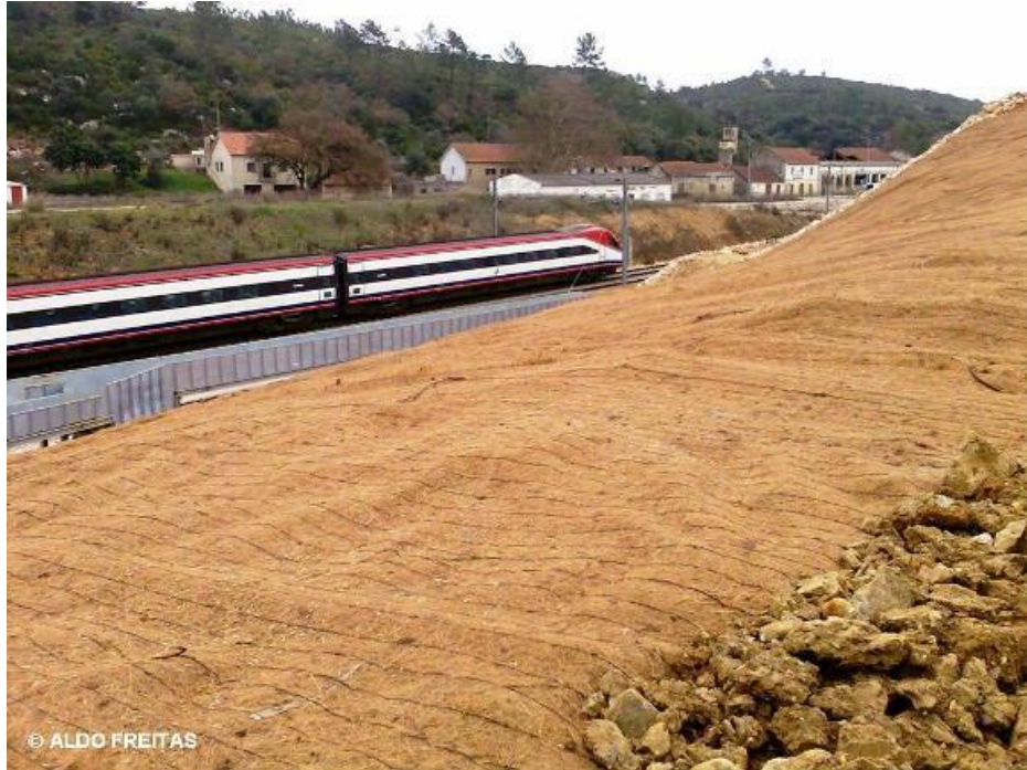
Figura 6 - Sementeira realizada junto à Estação de Fátima (Vale dos Ovos, Tomar) após à modelação do terreno para segurança do talude (Freitas, 2008).
