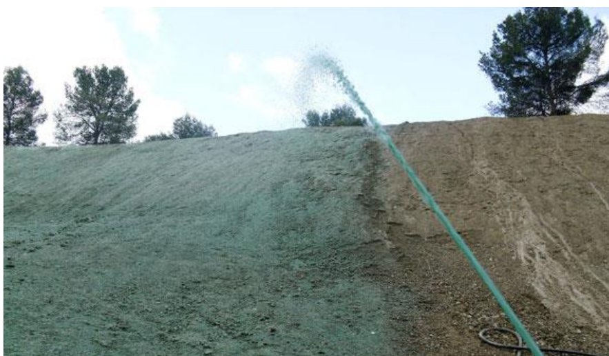
Figura 8 - Aplicação da técnica hydromulch em uma encosta com o intuito de combater efeitos erosivos no local (Miguez, 2014).
