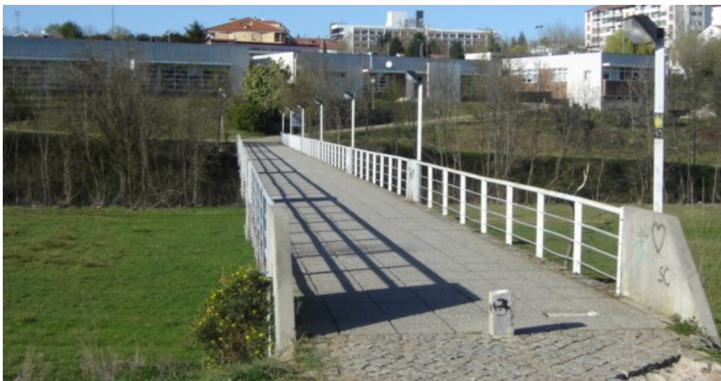
Figura 4 - Distribuição espacial da iluminação no viaduto
