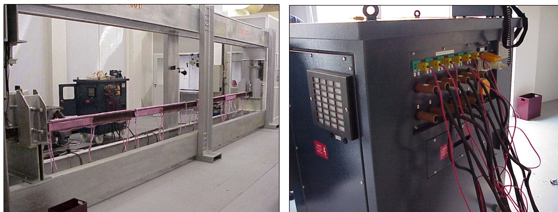
Fig. 8.35 – Sistema gerador de potência eléctrica – térmica.
