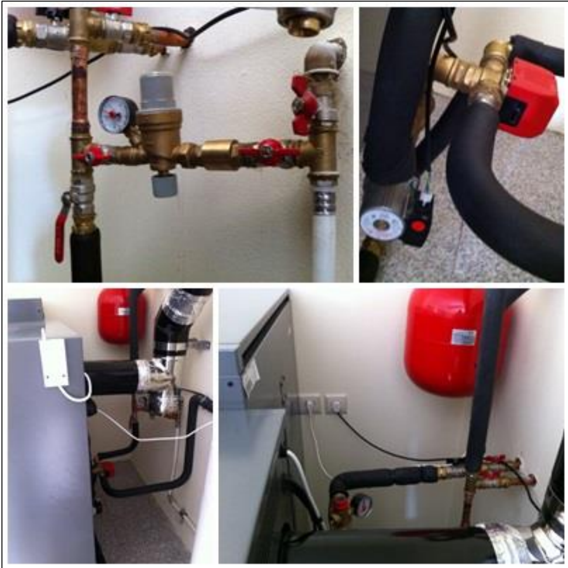
Figura 63 - Vários componentes da instalação da caldeira.
