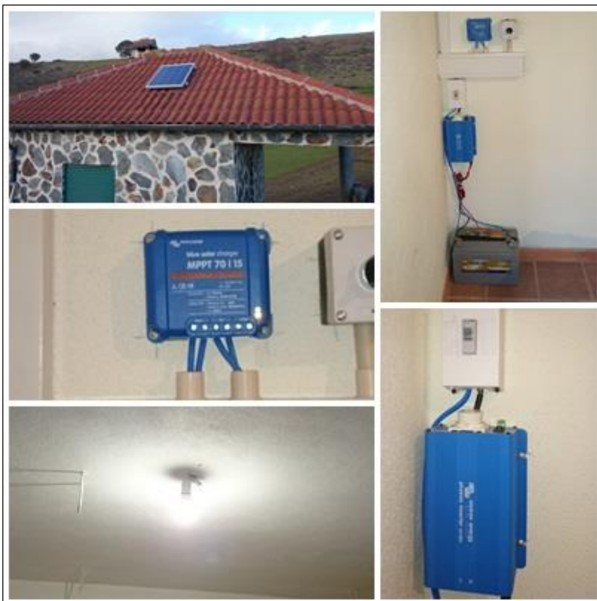
Figura 45 - Instalação de um sistema isolado para iluminação.
