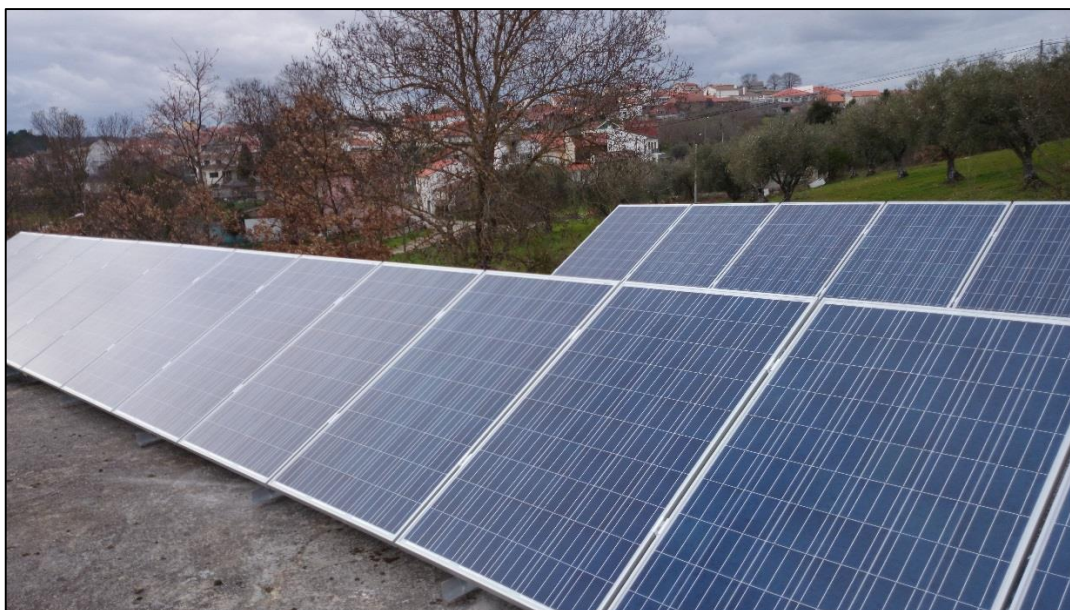
Figura 40 - Aspeto final da montagem dos painéis.
