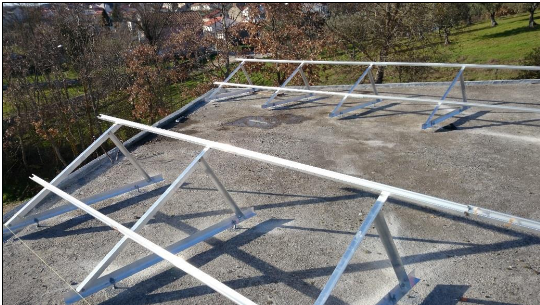
Figura 39 - Estrutura montada com inclinação de 30°.
