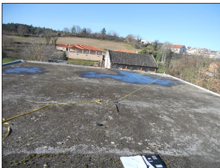
Figura 38 – Telhado sobre o qual ocorreu a instalação.
