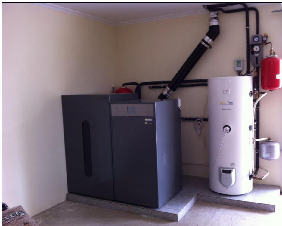
Figura 64 - Aspeto final da instalação concluída da caldeira.
