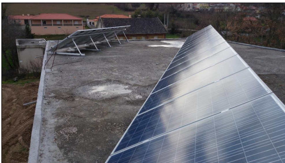
Figura 41 - Outra perspetiva do aspeto final da montagem dos painéis.
