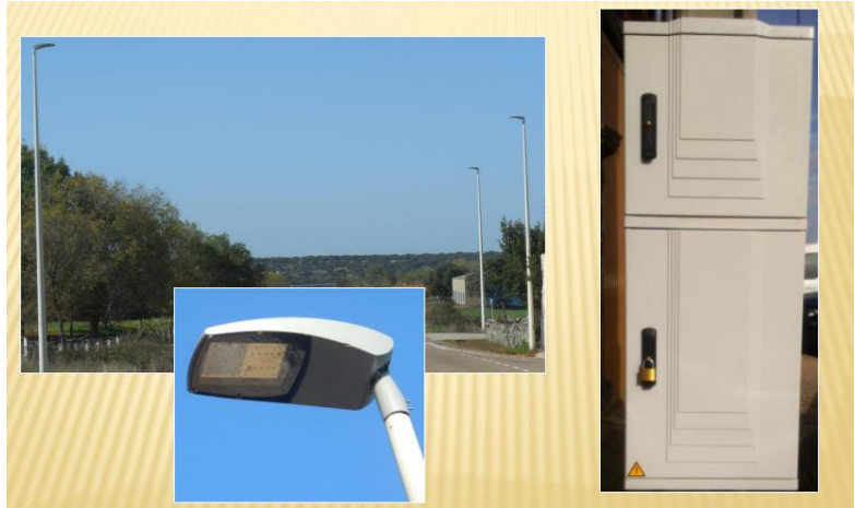
Fig. 5.22 - Luminárias LED e quadros elétricos substituídos
