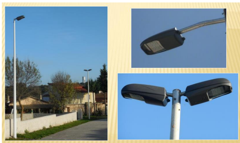
Fig. 5.21 - Luminárias LED da Iluminação Pública depois do Projeto
