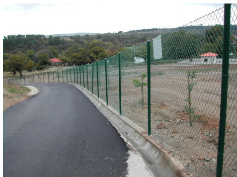
Pormenor da vedação da escombreira
