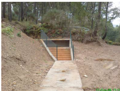
Saída da galeria, após restituição do Efluente
