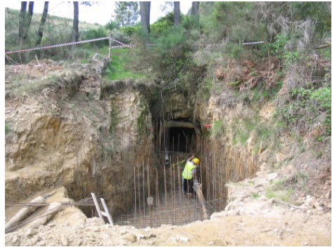
Obras da unidade de tratamento de efluentes de mina
