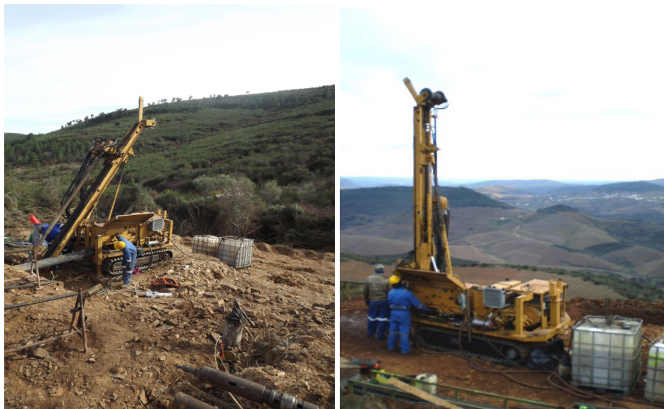
Figura 12 – Execução de sondagens carotadas.
