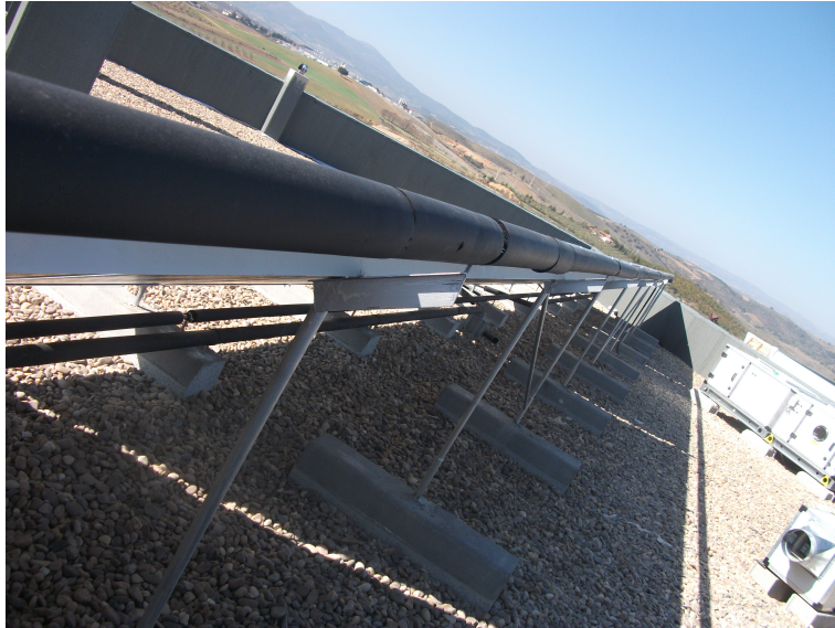
Figura 3.23: Estructura trasera de colectores solares
