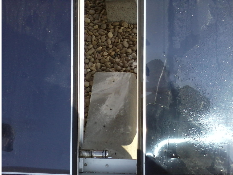
Figura 3.21: Conexión entre colectores
