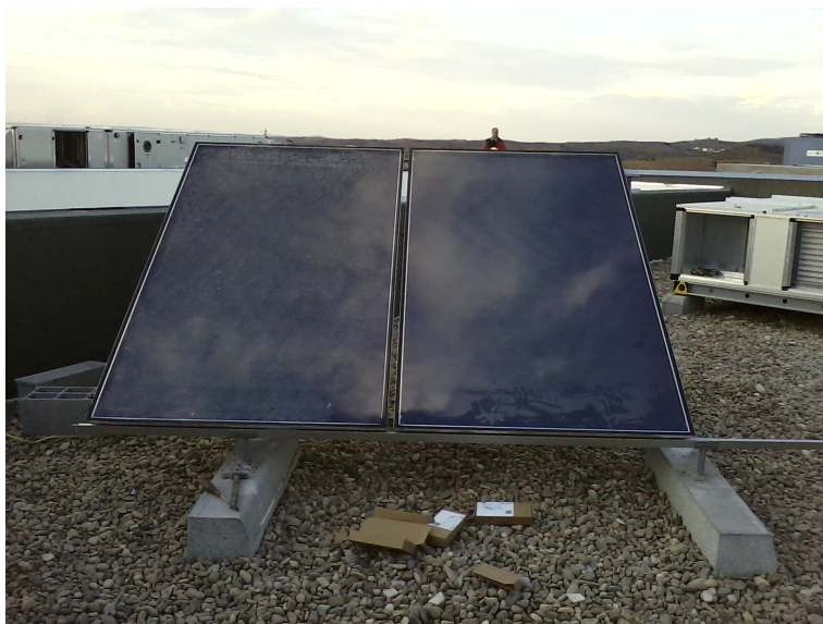
Figura 3.20: Colocación de colectores solares
