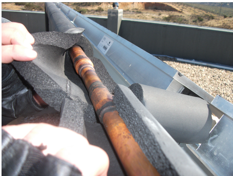
Figura 3.22: Colocación de aislante para tuberías
