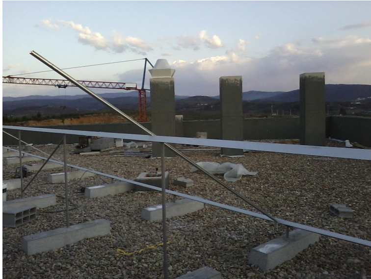
Figura 3.19: Construcción de base para colectores solares
