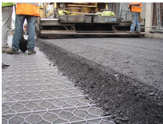
Figura 2.7- Grelhas aplicadas na reabilitação de pavimentos rodoviários (Jacinto M. A., 2011)
