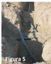
Figura 5 – Instalação das condutas para a água de rega
