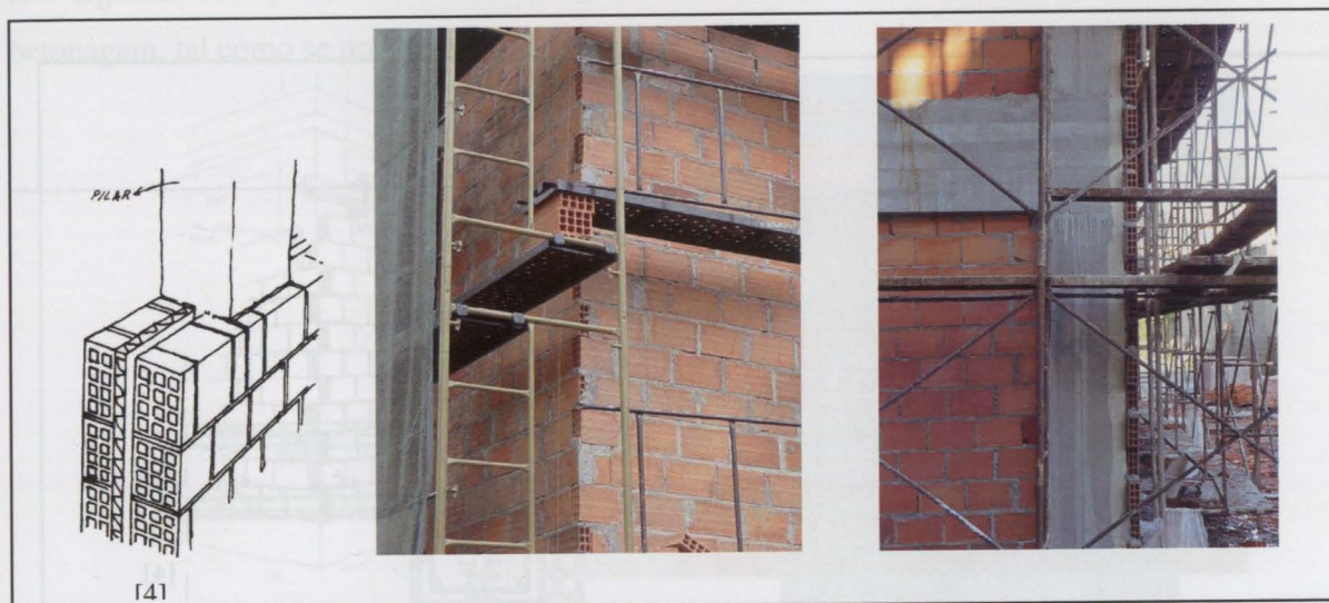
Figura 2.4 – Correção térmica pelo exterior em zona de pilar
