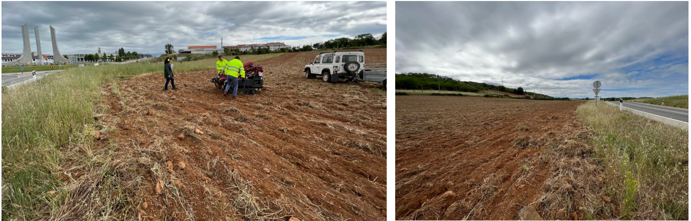
Figura 2 – Local de realização dos ensaios e equipamento de perfuração.
