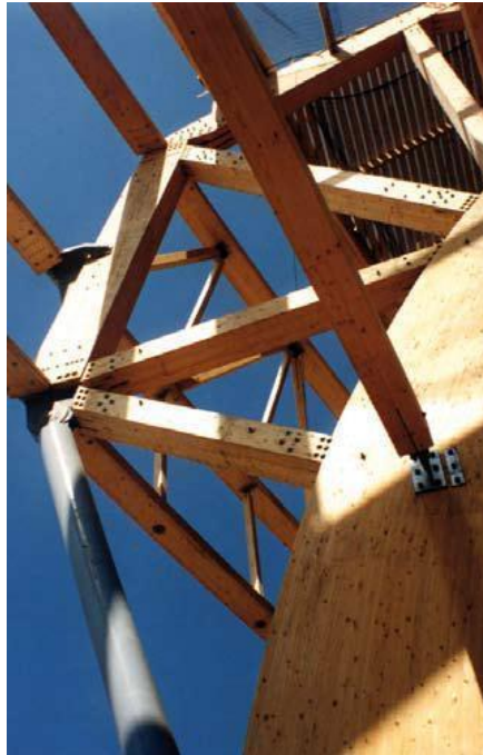
Figura 11 - Vista aproximada do arco de MLC (14)
