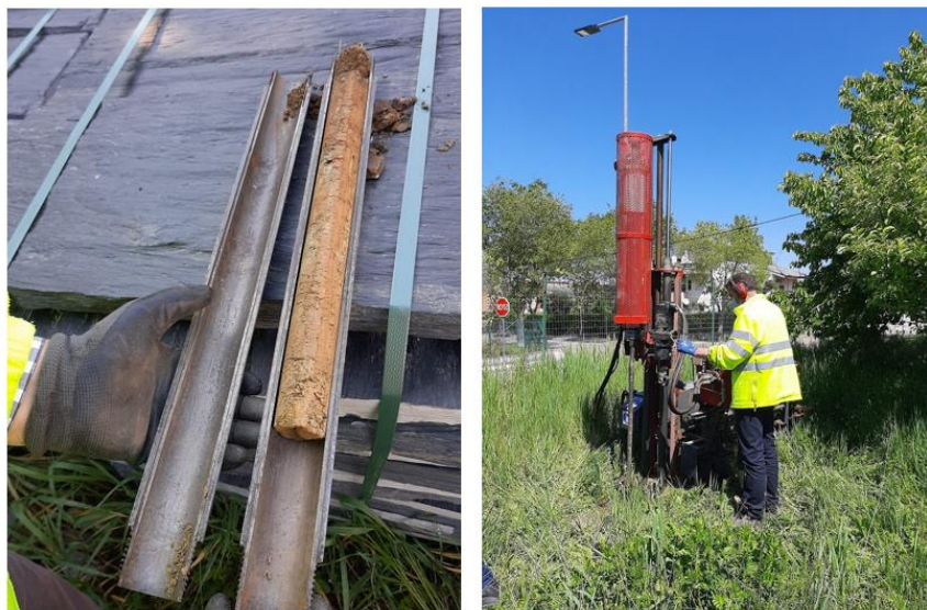
Figura 4- Equipamento do ensaio SPT (amostrador normalizado de Terzaghi e dispositivo automático de queda)
