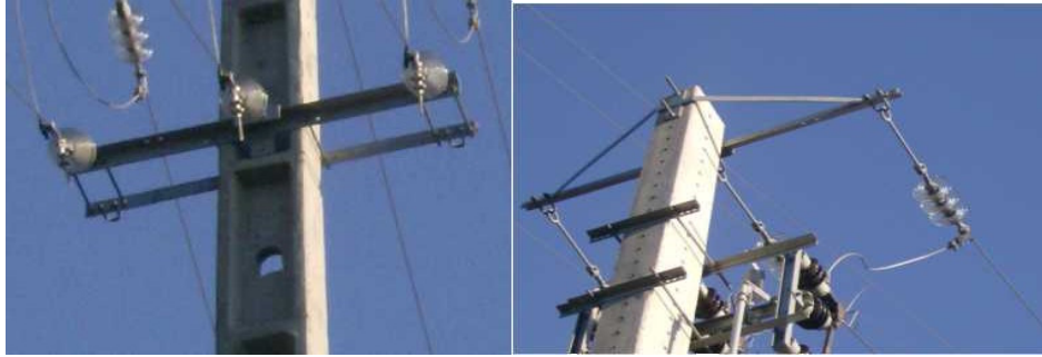
Figura 13 - Cadeia de amarração descendente e ascendente
