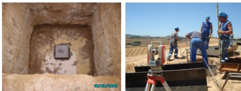
Figura 40 - Montagem e regulação de bases
