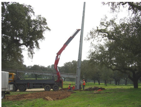
Figura 44 - Colocação de apoio de betão
