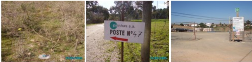
Figura 38 - Reconhecimento do traçado e implantação do estaleiro
