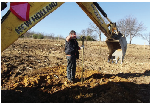
Figura 4.17 – Colocação do tutor juntamente com a planta. Colocación del tutor en conjunto con el árbol.
