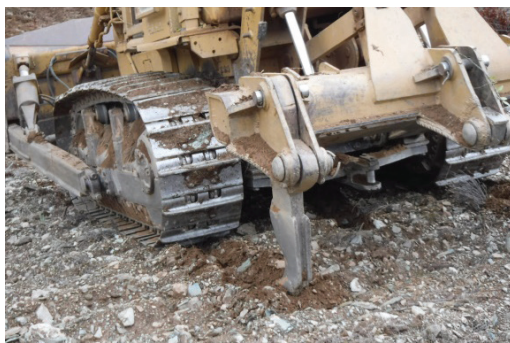
Figuras 4.3 e 4.4 – Subsolação ou ripagem. Subsolado o ripado.
