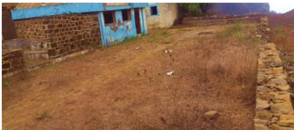
Figura 17: Local da instalação da minicentral FV
