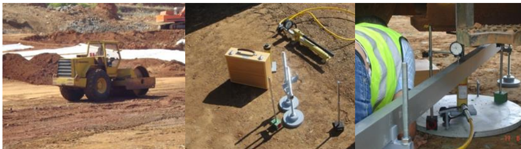
Figura 4.3 – Equipamentos e meios usados durante o ensaio ECP (LG, ESTIG)
