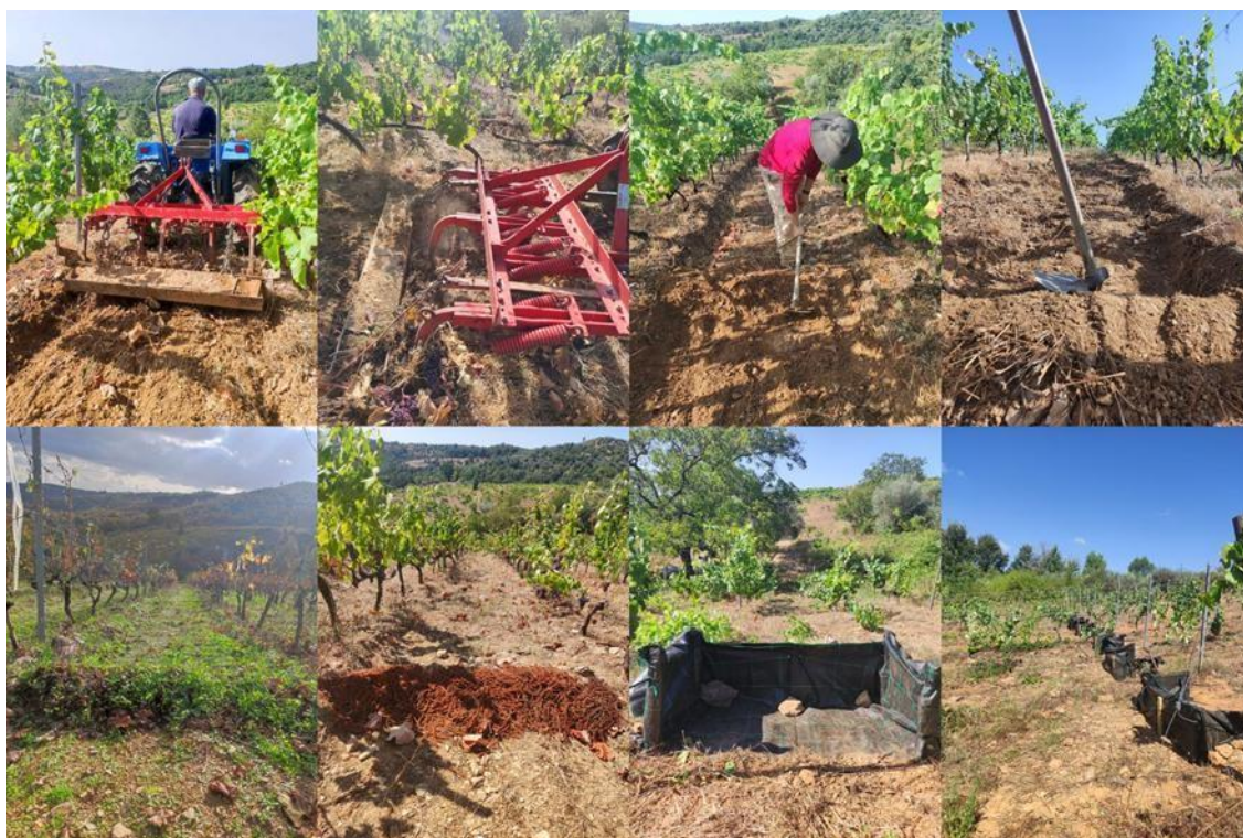
Figura 3 – Construção das barreiras de erosão e das armadilhas de sedimentos.
