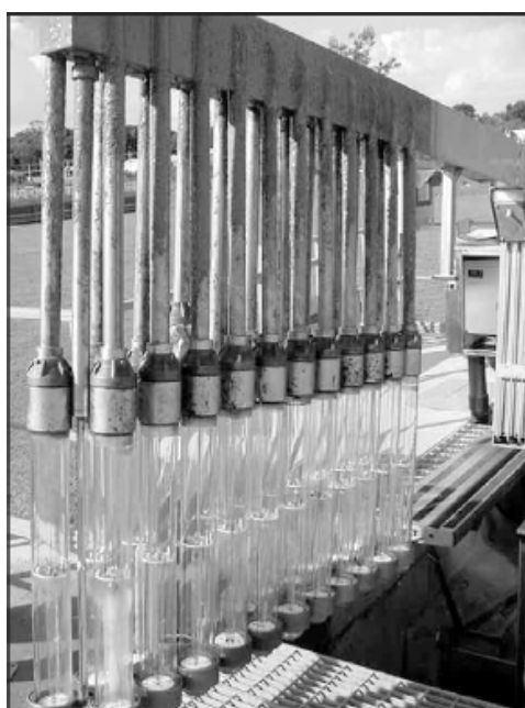
Figura 14. Arranjo de lâmpadas UV protegidas por um tubo de quartzo.
