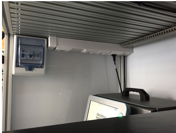
Figura 4.4: Montagem Final do Quadro Elétrico.
