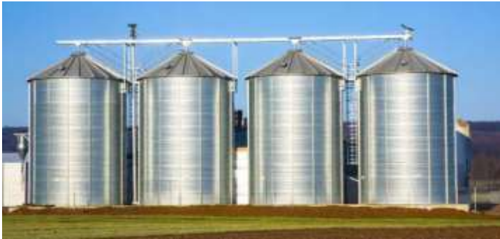
Figura 9: Silo vertical em aço
