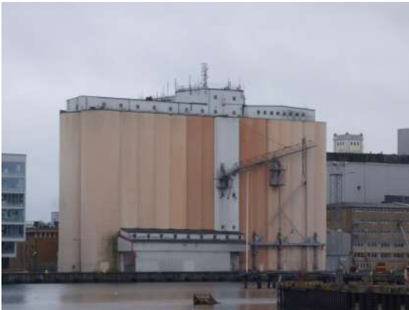
Figura 8: Silo vertical betão armado (Malmo Suécia)
